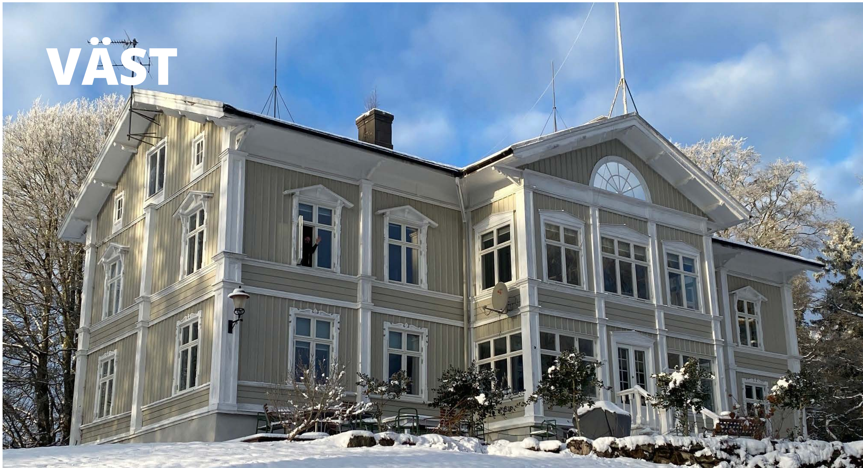
GBJ BYGG VÄSTS KONTOR I FLODA.
