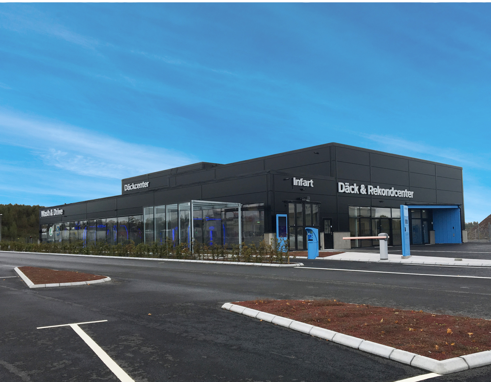
Ny däckanläggning på Bredasten.
