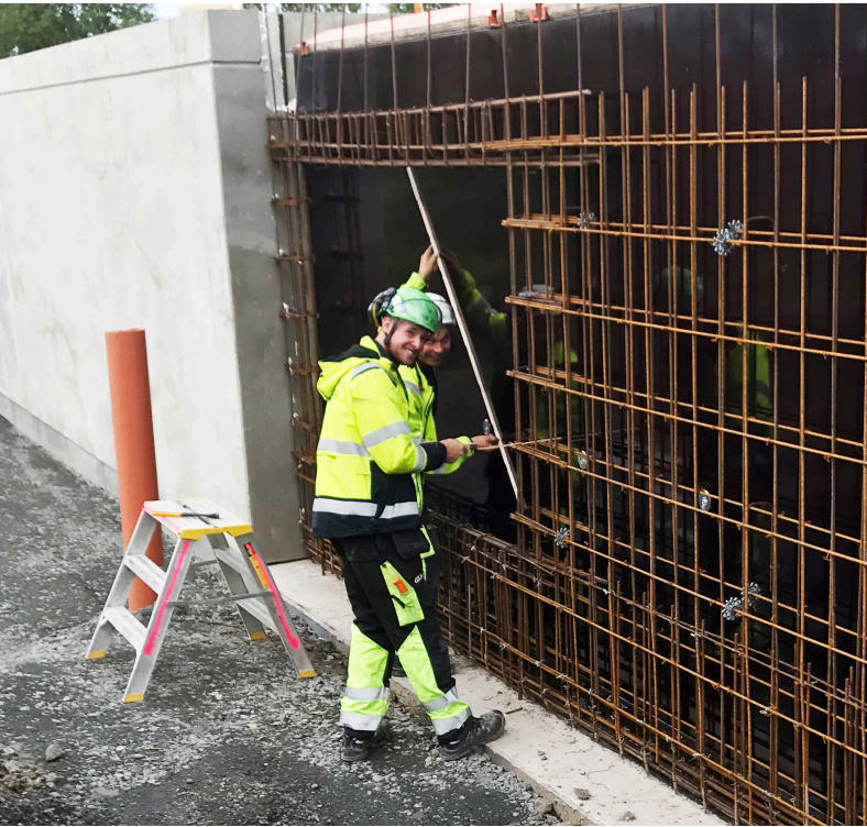
Petri Hätälä och Szymon Glazik kontrollerar storlek på avstängaren i väggen.
